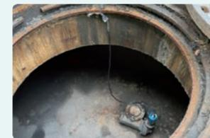
한난은 IoT 기술을 활용한 열수송관 누수탐지(청음) 기술을 도입해 적용 중이다. 이는 2개 이상 지점의 밸브에 누수음 수집센서를 설치하고 상관식 누수음 감지를 통해 누수여부 및 위치를 측정하는 기법이다. 교통소음 등의 잡음 구분이 가능하고, 인력기반 청음 진단에 비해 정확하다는 게 장점이다. 📌
